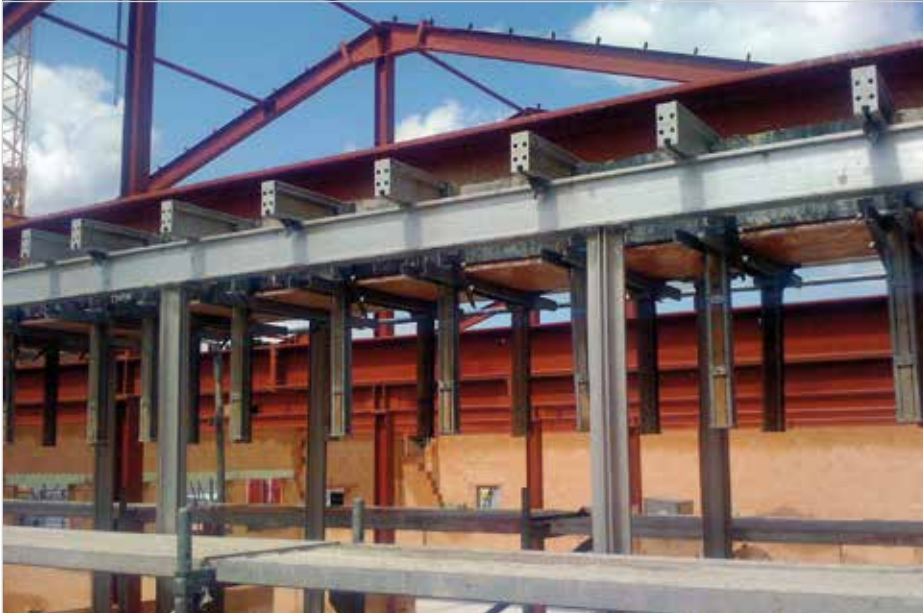
Unterzug mit Unterzugzwinge U-HV auf Alu-Flex-Deckenschalung mit Alu-Schalungsträger TITAN 160 H.
