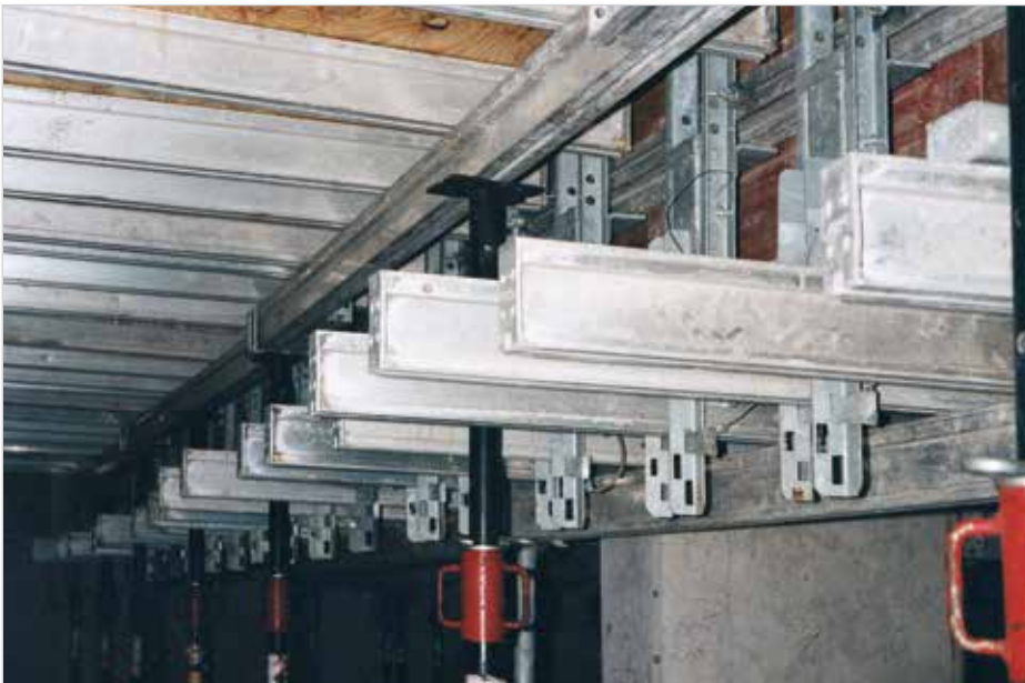
Deckensprung mit Unterzugzarge auf Alu-Flex-Deckenschalung.
